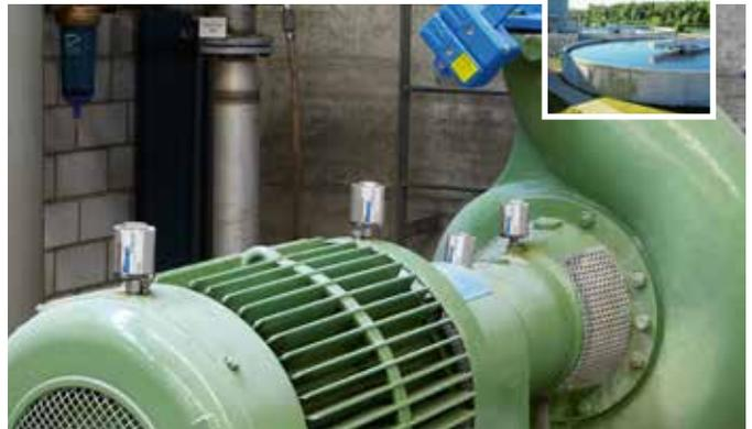
60 ml Schmierstoffspender auf dem Elektromotor und der Antriebswelle sorgen für die kontinuierliche Schmierung einer Zentrifugalpumpe.
