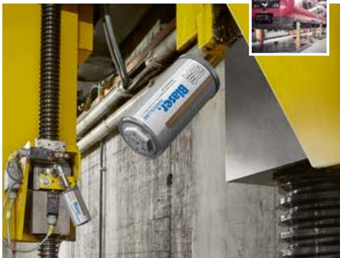
Spindeln einer Hubanlage für Eisenbahnwaggons und Lokomotiven werden mit einem Blaso-Pro 125 ml über 12 Monate geschmiert.
