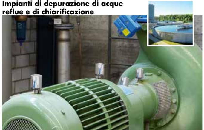
I lubrificatori da 60 ml sul motore elettrico e sull'albero di trasmissione garantiscono la lubrificazione continua di una pompa centrifuga.
